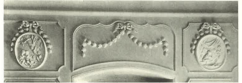
DÉTAIL DES FENÊTRES (Bibliothèque)
