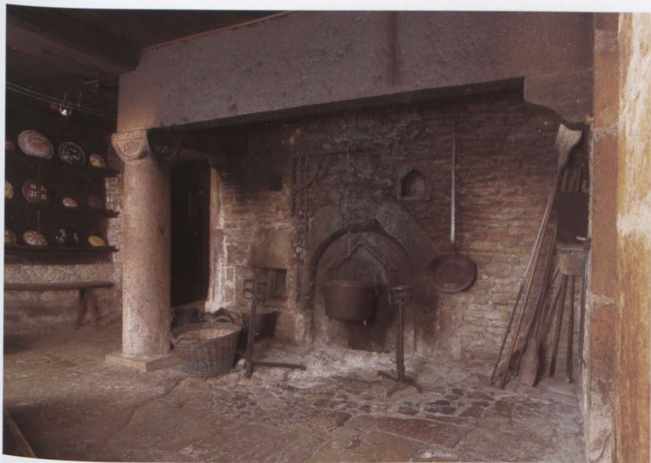
L'âtre d'une maison paysanne avec sa gigantesque cheminée, ou « tué », où se conservent les salaisons.
